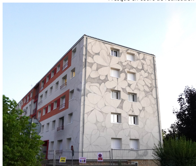
Fresque en cours de réalisation
