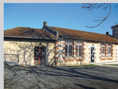
Monfaucon Travaux aménagement bâtiment communal 9 000 €
