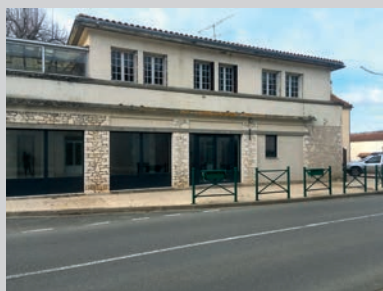
Pomport Début des travaux du réaménagement d'un ancien local commercial 15 000 €
