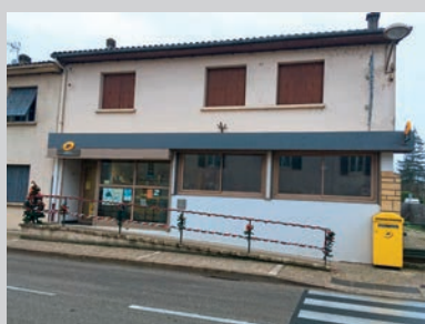
Bouniagues Réhabilitation d'un bâtiment communal 21 000 €
