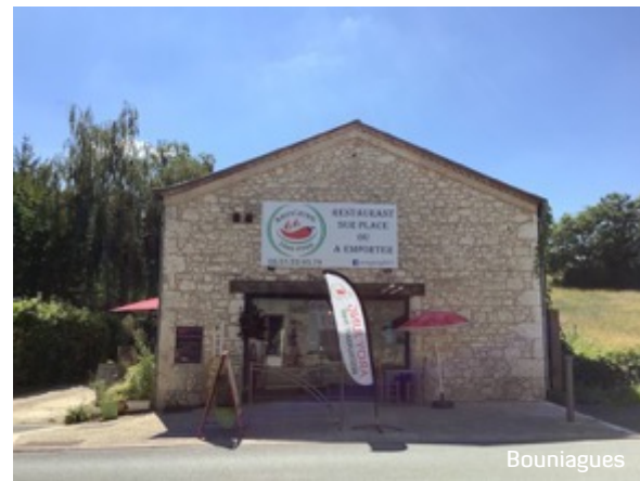
Enseigne sur façade en pierre apparente ne mettant pas en valeur le bâti.
